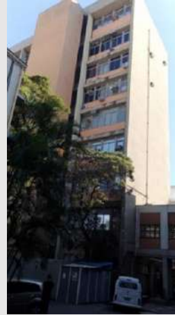
EDIFÍCIO CIÊNCIAS BIOMÉDICAS (ECB) - EDIFÍCIO ANTONIO C. M. PAIVA Camila M. Y. Asanuma / Valter T. B. Oliveira
